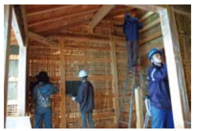
建設中の里山長屋。竹小舞の上に土を塗る 写真提供：小山宮佳江
